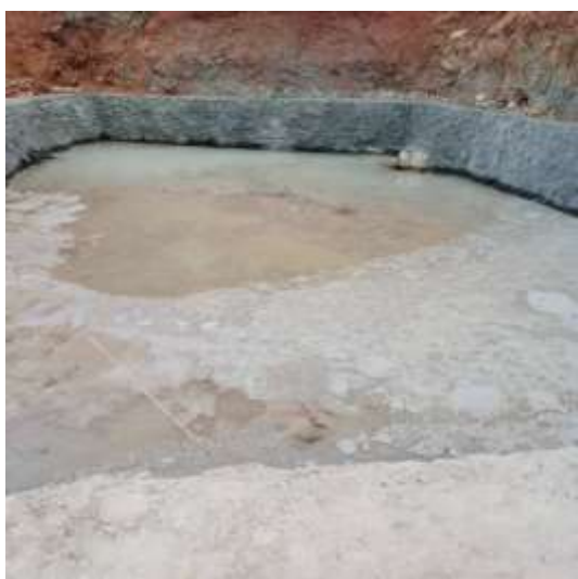
图 4-16 矿区初期雨水沉淀池（兼应急水池）
